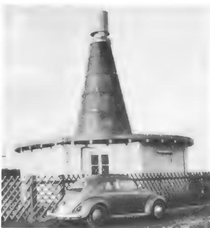
Bild 3. UKW-Drehfunkfeuer VOR mit TACAN-Zusatz in seiner heutigen Form (Anlage bei Fulda)
